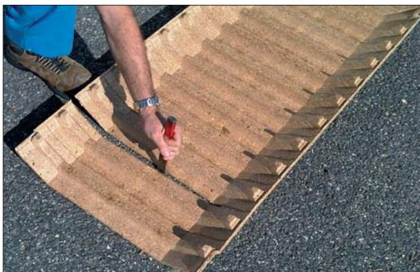
La coupe en transversal se fait rapidement à l'aide d'un burin et d'un marteau grâce à ses pré-découpes tous les 10 cm. Le jeu de pose supérieur à l'écartement entre deux pré-découpes, permet de s'adapter à toutes les longueurs de travées.
