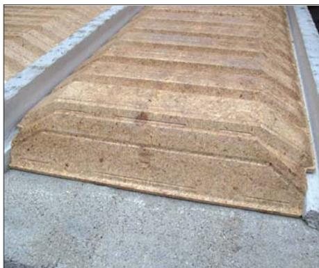
Pose de l'EBS en bout de travée avec bouchon incorporé. Toujours commencer par les extrémités avec les bouchons sur les arases
