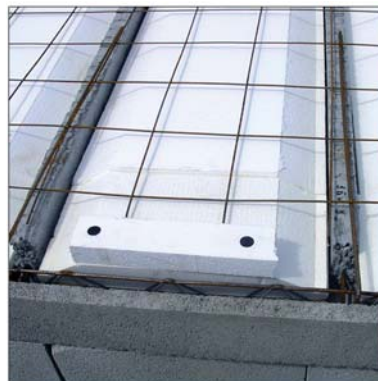
Plancher Hourdis Polystyrène Rupteur Total : Stoptherm EP
