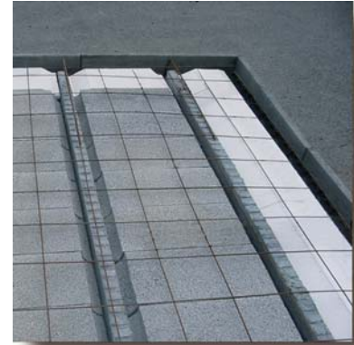
Plancher Hourdis béton Rupteur Partiel: Stoptherm ES
